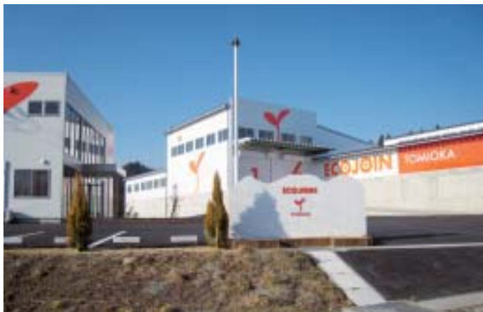
農林水産省バイオマス・ニッポン総合戦略高度化推進事業 「エコジョイン富岡」（福島県富岡町）
