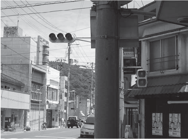
交通の麻痺・市内の交差点 (視察時点でも信号が点いていない)
