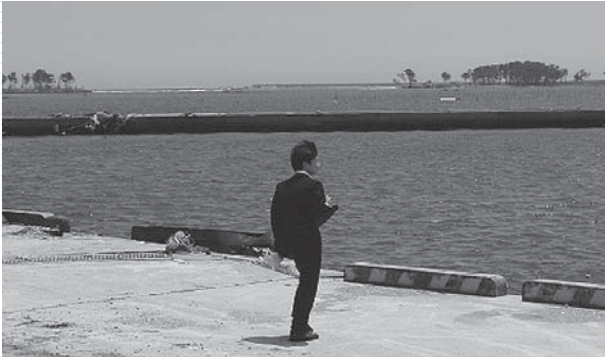
写真① 津波により堤防が流出、太平洋と繋がり波（中央奥）が見える松川浦
