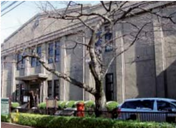
県内初の鉄筋コンクリート造の草加小学校西校舎。 現在は歴史民俗資料館として活用されている
