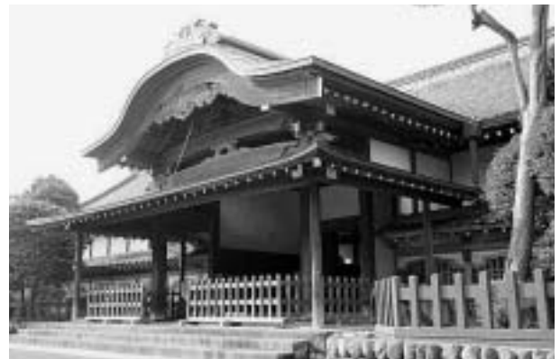
現在改修作業中の川越城本丸御殿正面
