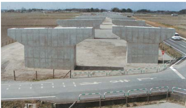
総合評価入札制度現場において独自の技術提案によって金額順位2番手以下から逆転受注した圏央道栢間沼第1高架橋下部工事
