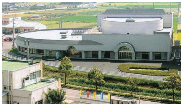
同社が建設した大里町（現熊谷市）生涯学習センターの直径40mの半円形の図書館部分は一本の柱もない大空間で、県産材の杉・桧がふんだんに使用されている
